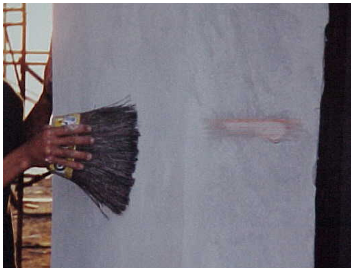
Fotografia 1 – Limpeza da base
