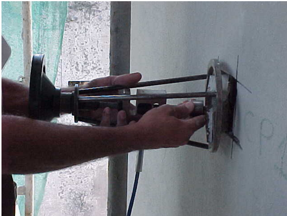
Fotografia 51 – Resistência a tração do emboço
