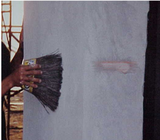
Fotografia 13 - Limpeza da base
