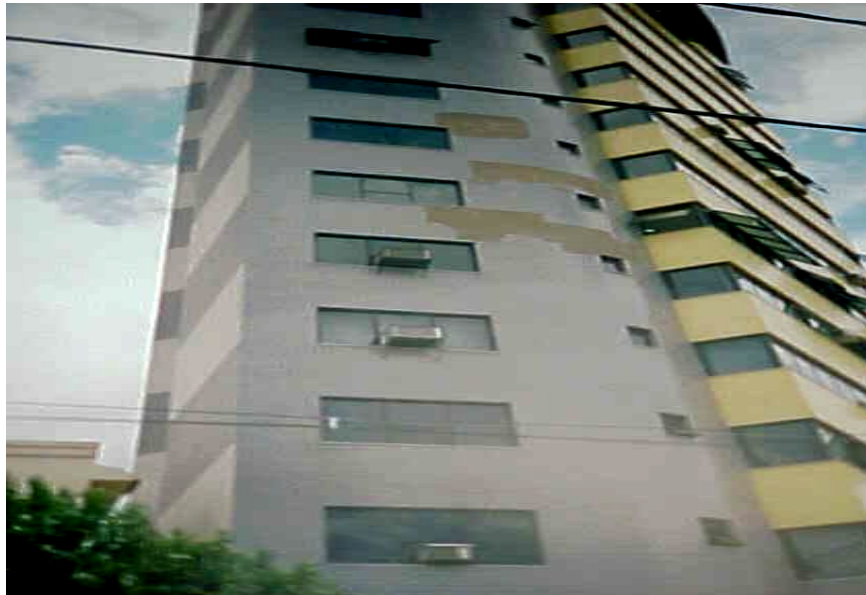
Fotografia 29 - Estruturas em balanço
