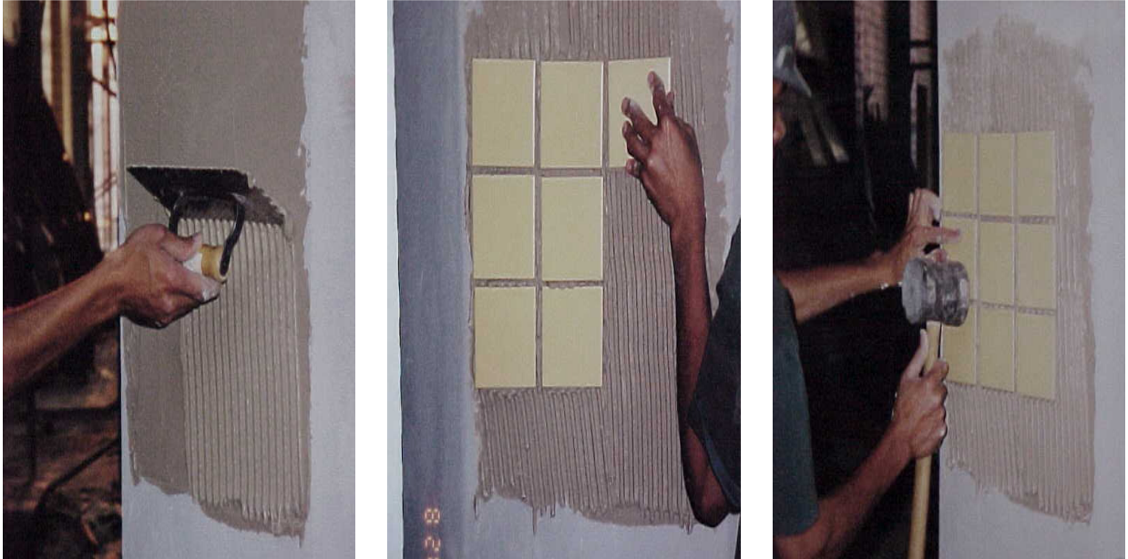
Fotografias 15, 16 e 17 – passo a passo para assentamento do revestimento cerâmico
