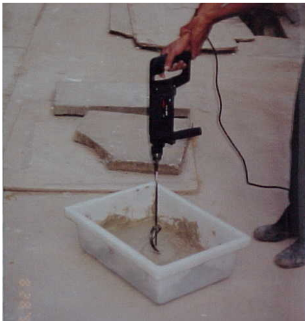
Fotografia 14 - Preparo da argamassa colante
